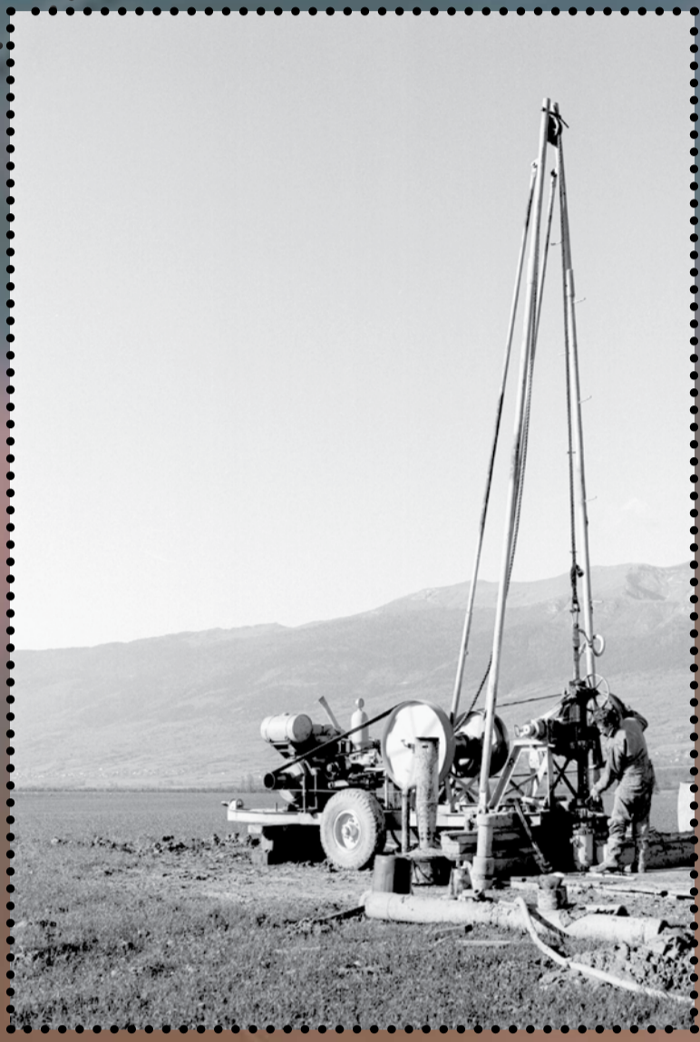
Borings on the future ISR site, Novembre 1963
